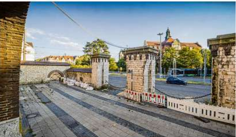
Die Mauer am Ehinger Tor versperrt derzeit noch den Fußweg entlang des Bismarckrings. Foto: Matthias Kessler
